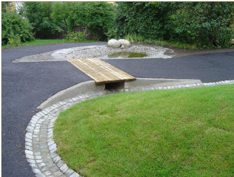
Åpne vannrenner leder takvann og overflatevann til dammen, samtidig fungerer rennene som ledetråder og retningsanvisning for de psykisk utviklingshemmede brukerne.
